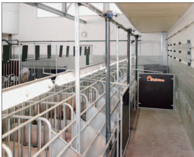
Einsatz des Rieselkanals im Deckzentrum
