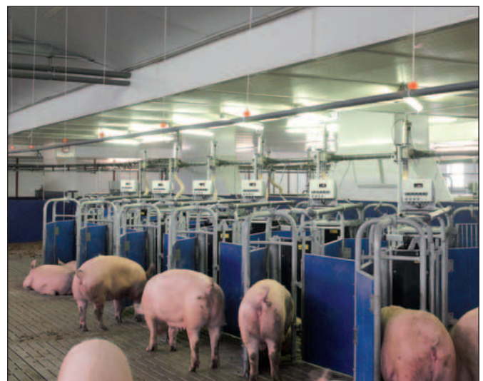
Zuluftführung über einen Rieselkanal im Wartestall für Sauen
