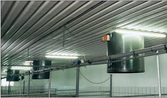
Einsatz der Axialventilatoren in einem Stall mit Diff-Air-Decke
