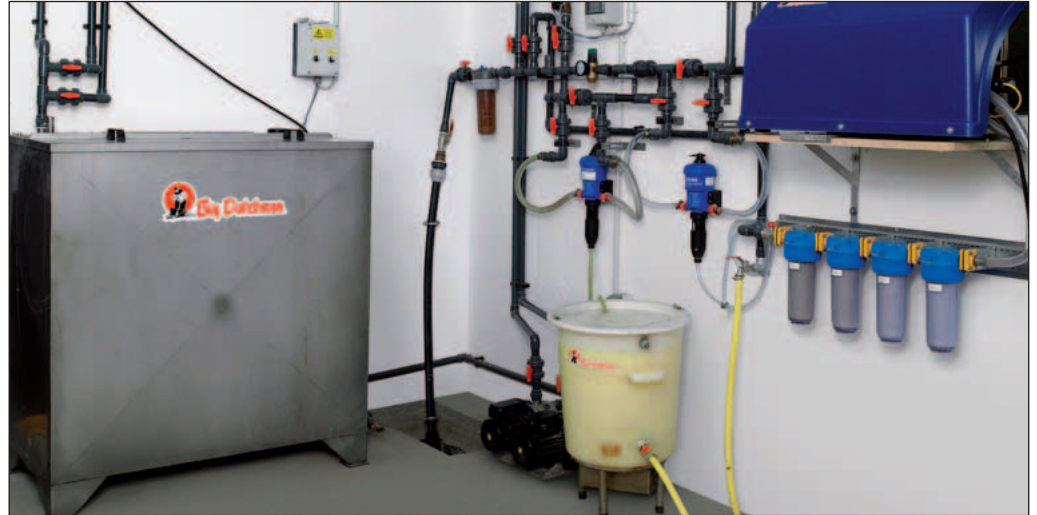
Vorraum mit kleinem und großem Medikamentenmischbehälter
