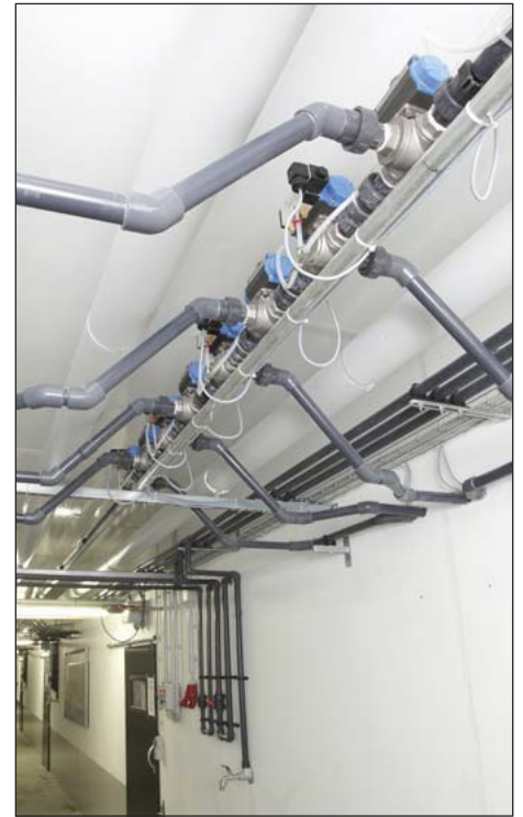
Installation der Futterventile im Zentralgang
