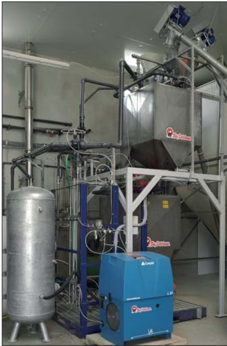
HydroAir-Synchron – mit dieser Doppeltankanlage ist die Versorgung größerer Tierbestände ohne lange Wartezeiten möglich
