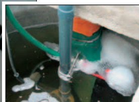
Einsatz einer Tauchpumpe zur Wasserversorgung der Coolbox
