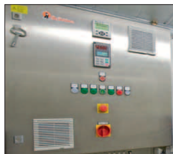
Individuell geplanter Schaltschrank
