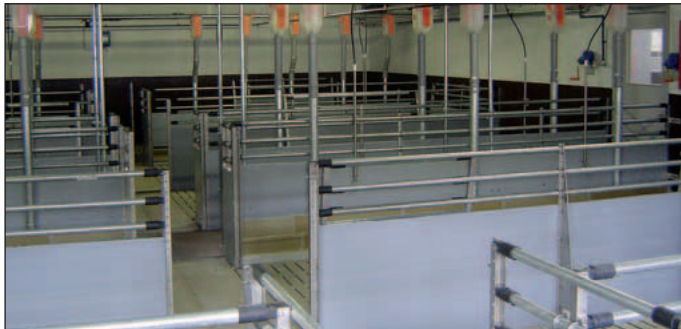
Einsatz von Verstärkungsständern im Wartebereich für Sauen
